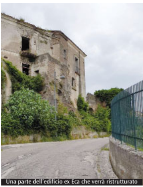
Una parte dell'edificio ex Eca che verrà ristrutturato
